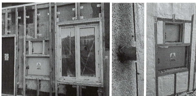
Rys. 4. Konstrukcja szkieletowa na złączach podatnych firmy FlexAnd Robust oraz wypełnienie pianką (archiwum autora)
