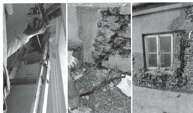
Rys. 3. Iniekcja złączy polimerowych FlexAndRobust (archiwum autora)
